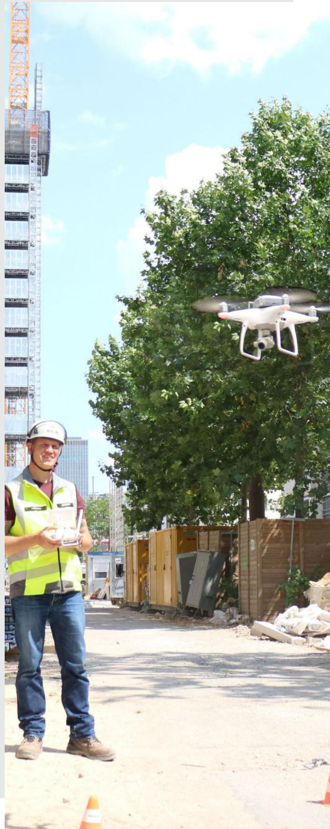
der entsprechenden Software werden Baufortschritte am PC dargestellt. Doch auch bei ad-hoc Überprüfungen durch Projektmanager, Bauleiter oder Bauaufsicht bietet die Drohne und ihr Blick aus der Luft einen echten Mehrwert. Per Live-Bild-Übertragung lassen sich Baufortschritt, Vorräte oder Leitungen bequem, schnell und sicher kontrollieren – ganz ohne eine zum Teil zeitaufwendige und bisweilen sogar gefährliche Begehung.
